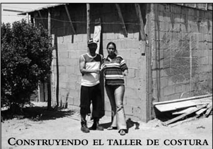
CONSTRUYENDO EL TALLER DE COSTURA
