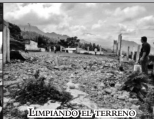
LIMPIANDO EL TERRENO
